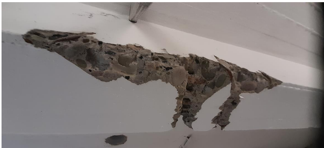
Obr. 13 Sonda uprostřed rozpětí stropního trámu
