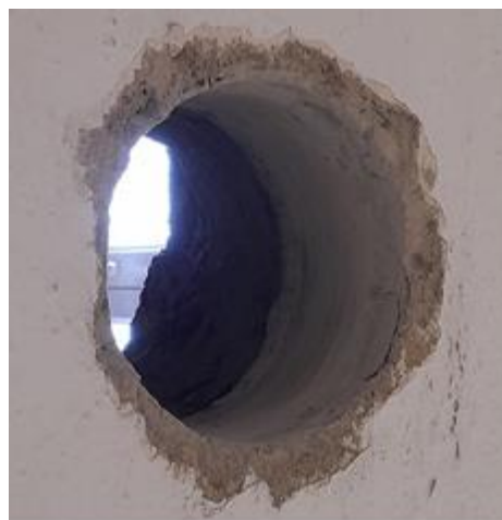
Obr. 9 a 10 Jádrový odvrt – spodní část s omítkou a celkový profil
