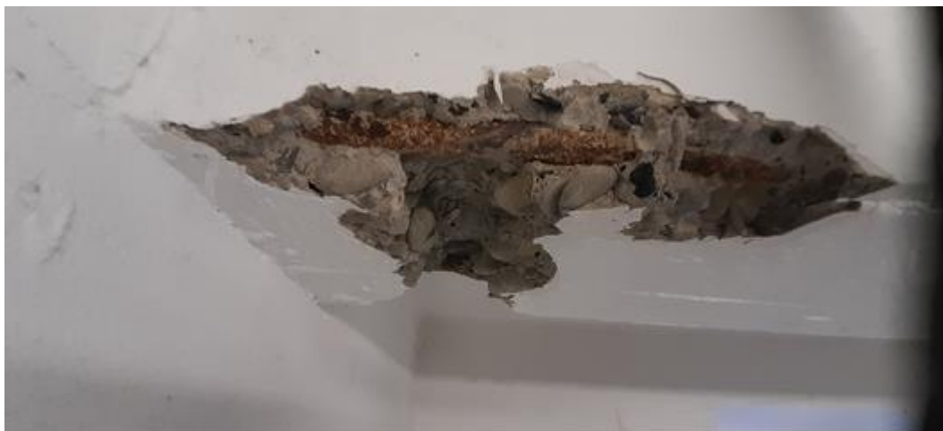
Obr. 15 Sonda do stropního trámu v místě podpory
