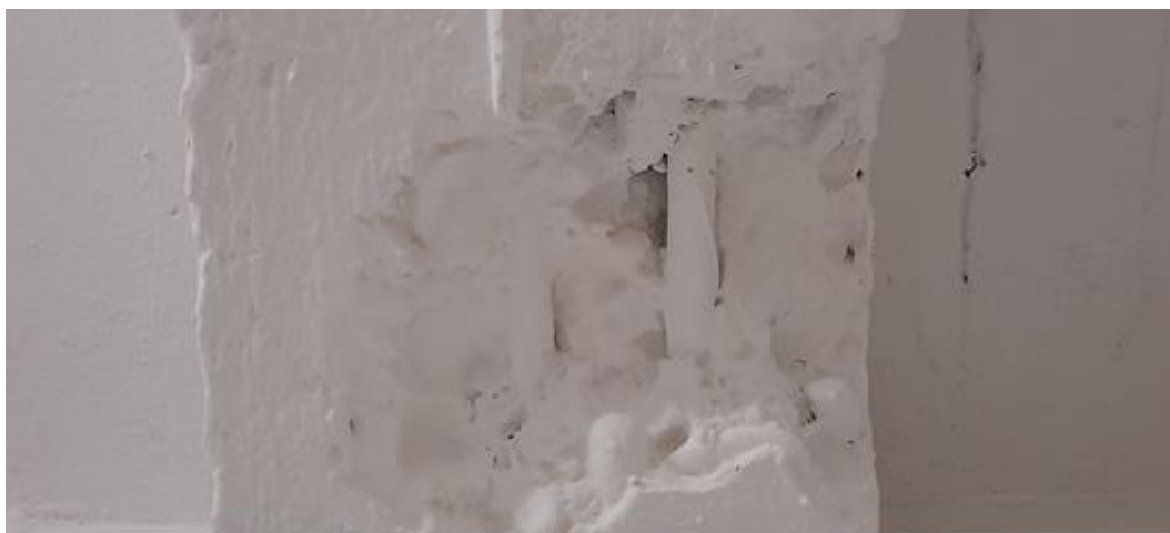
Obr. 17 Dolní nekrytá výztuž na stropním trámu
